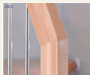
Stabile Handlaufverbindung durch Keilzinkung
