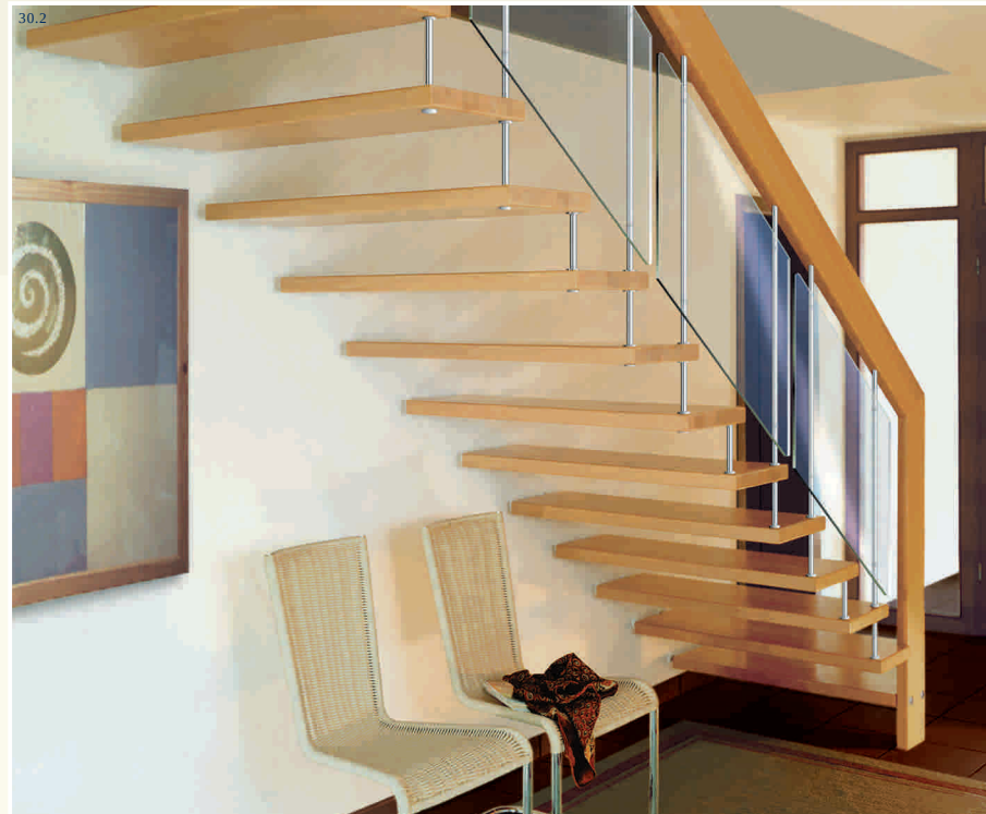
Geländer mit Glasfüllungen
