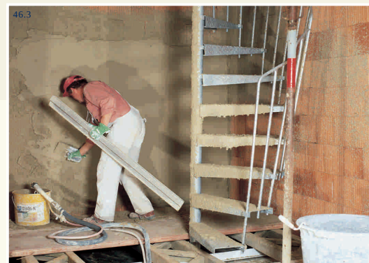
Genügend Platz für Arbeiten im Treppenhaus
