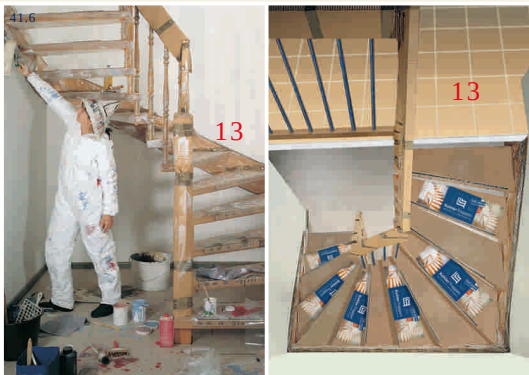
13 Wiederverwendbarer Treppenschutz: Jede Treppe erhält ein individuelles Schutzsystem. Sie wird verpackt eingebaut und ist sicher geschützt. Das System kann bei Renovierungen wiederverwendet werden.
