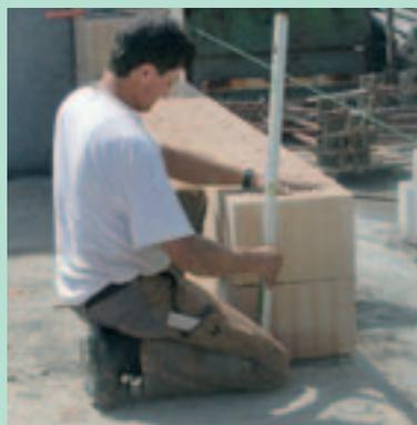
Der Klimatherm Planziegel wird schnell und passgenau versetzt. Ein leichtes Nachrücken ist möglich. Die Verarbeitungszeit beträgt je nach Jahreszeit ca. 4 Stunden in der Mörtelwanne und ca. 5-10 Minuten in der Lagerfuge. Direkte Sonneneinstrahlung und Wind verkürzen die Verarbeitungszeit.
