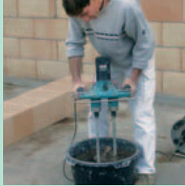
Wasser in sauberes Gefäß – z.B. 30 l Eimer von Colomix – vorlegen und unter ständigem Rühren mit dem Rührquirl den Trockenmörtel gleichmäßig einstreuen, bis ein homogener, klumpenfreier und geschmeidiger Mörtel entsteht. Richtwert: 7-8 l Wasser je 25 kg-Sack. Nach einer Reifezeit von 5-10 Minuten nochmals kurz mit dem Quirl durchmischen.
