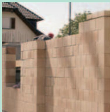
So entsteht rationell ein homogenes Ziegel-mauerwerk in hoher Ausführungsqualität. Das Ziegelmauerwerk ist aufgrund seiner Poren- und Kapillarstruktur ein besonders geeigneter Putzgrund und Putzträger.
